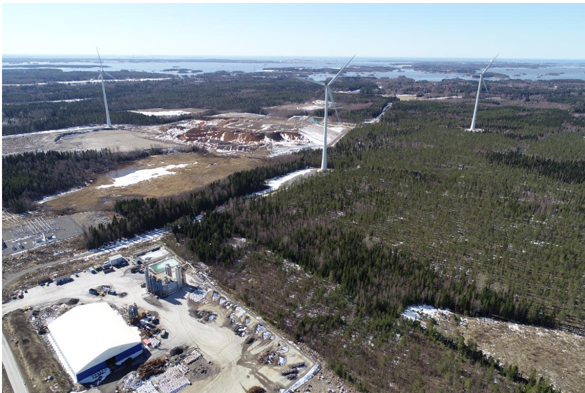
Fortum Waste Solutions:n laitos, sähköasema, Kuivattujärvi.
